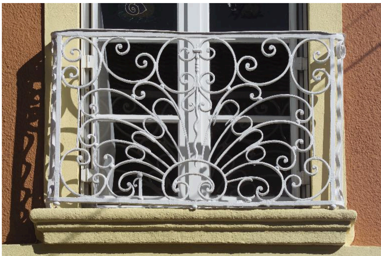
La façade n° 78 rue du Général-De-Gaulle, détail d'un balcon.
