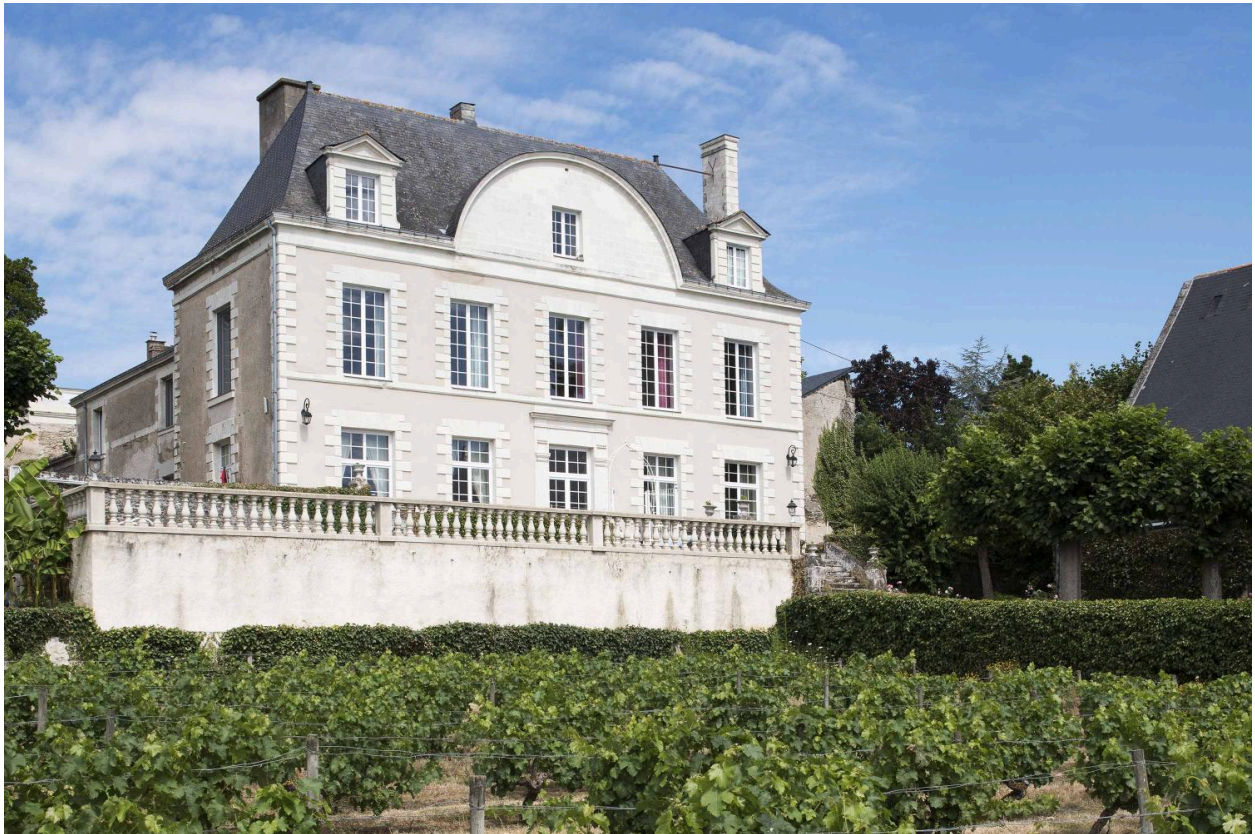
Vue de la façade principale depuis le sud.
