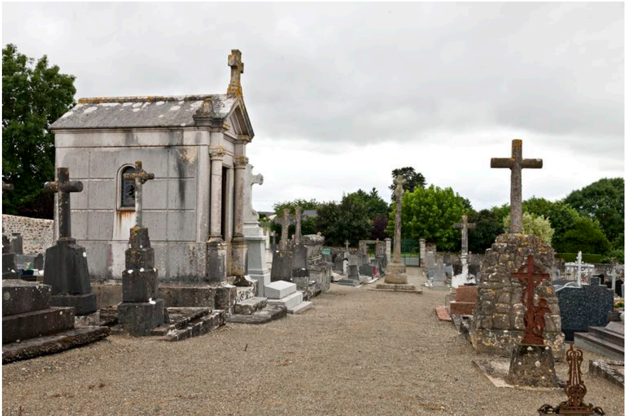
Vue de situation de la chapelle dans le cimetière.
