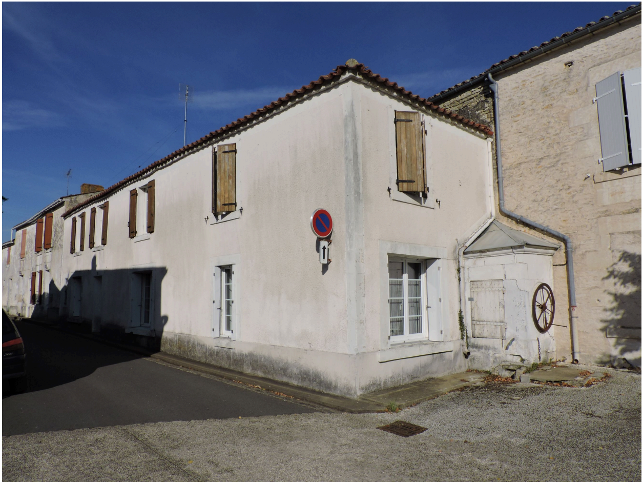
La maison vue depuis le sud-est.
