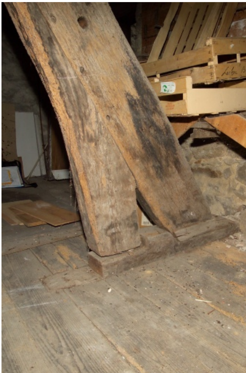
Détail de la charpente.
