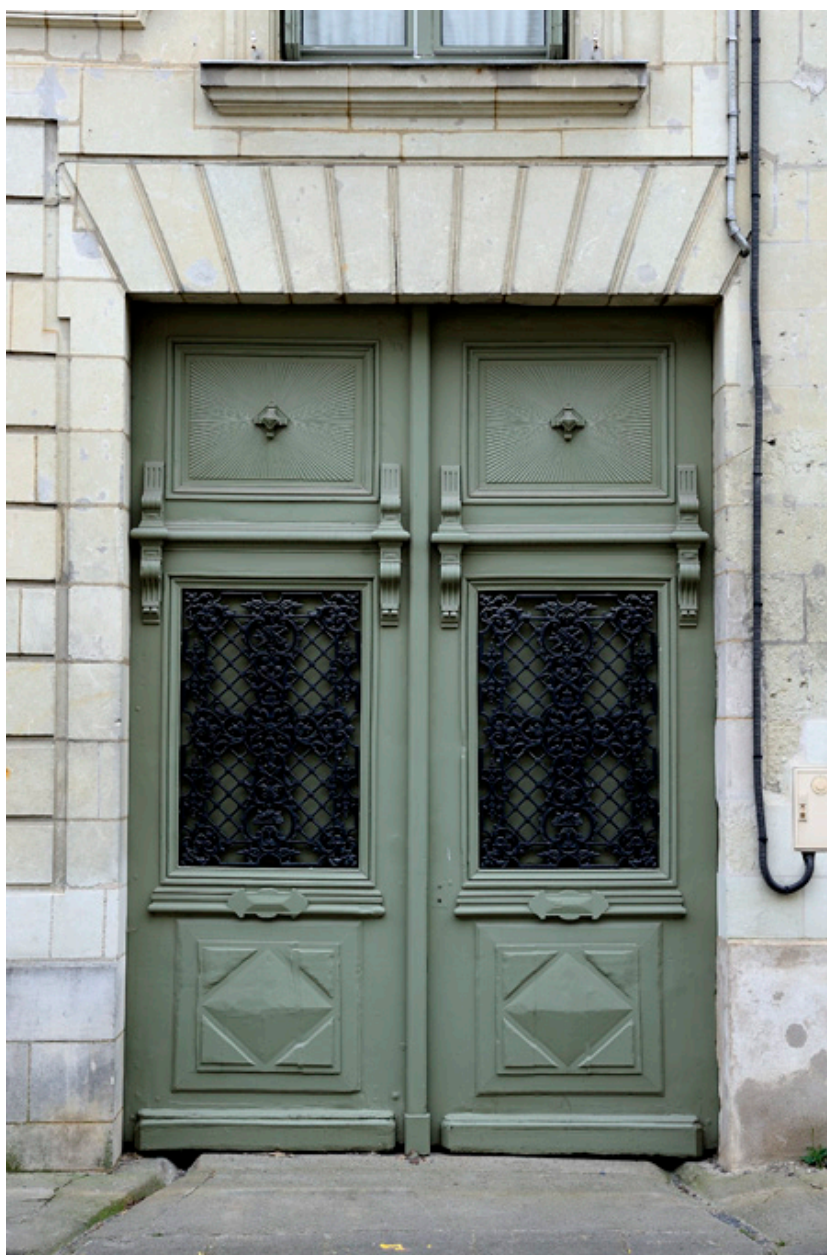
Porte du passage couvert.
