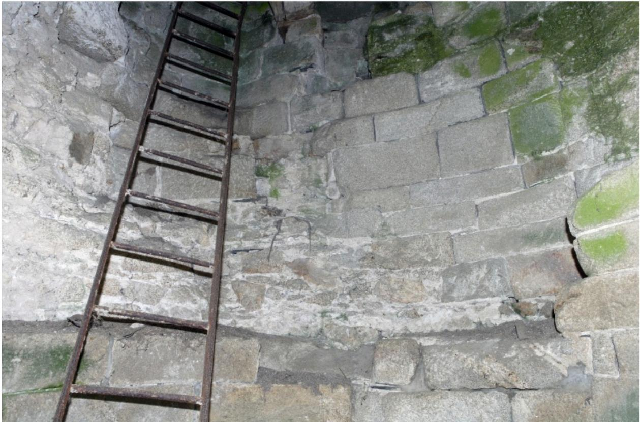
Vue intérieure du pied ; détail des buchages à l'emplacement du petit escalier primitivement accessible par une échelle et permettant d'atteindre l'étage.
