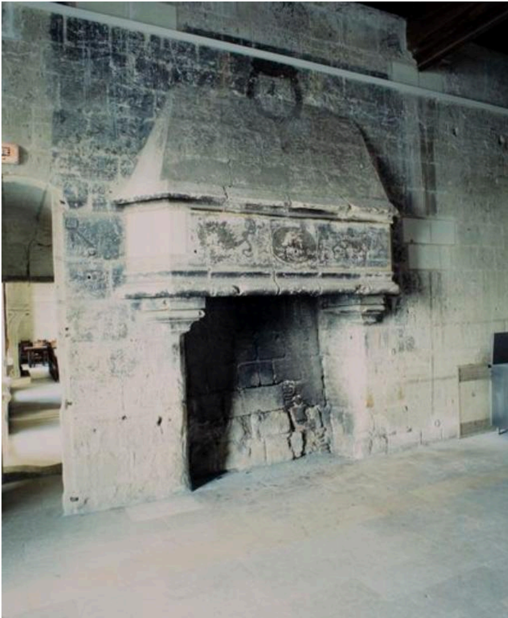
Rez-de-chaussée, tour ouest, salle avec cheminée à décor peint.
