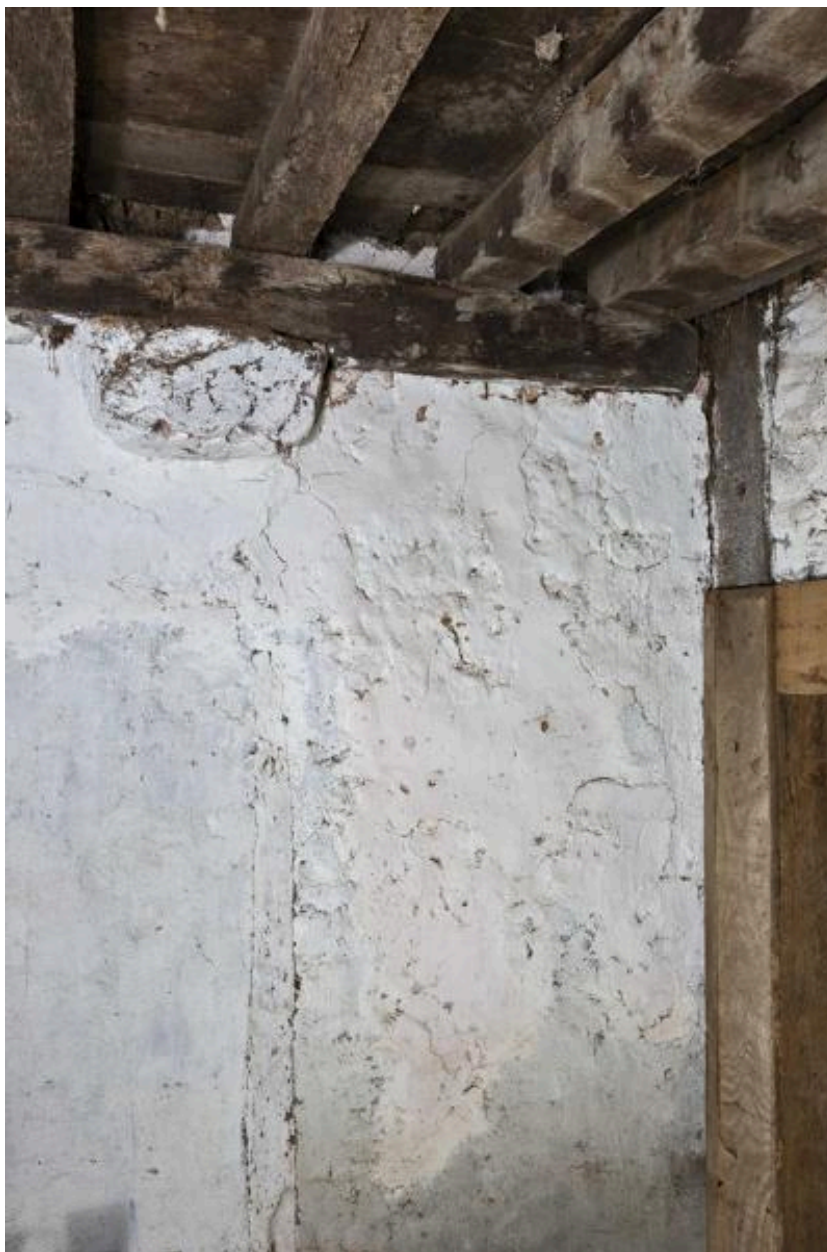
Poteau de l'ossature en bois de l'ancienne maison, angle sud-est de l'ancienne maison.
