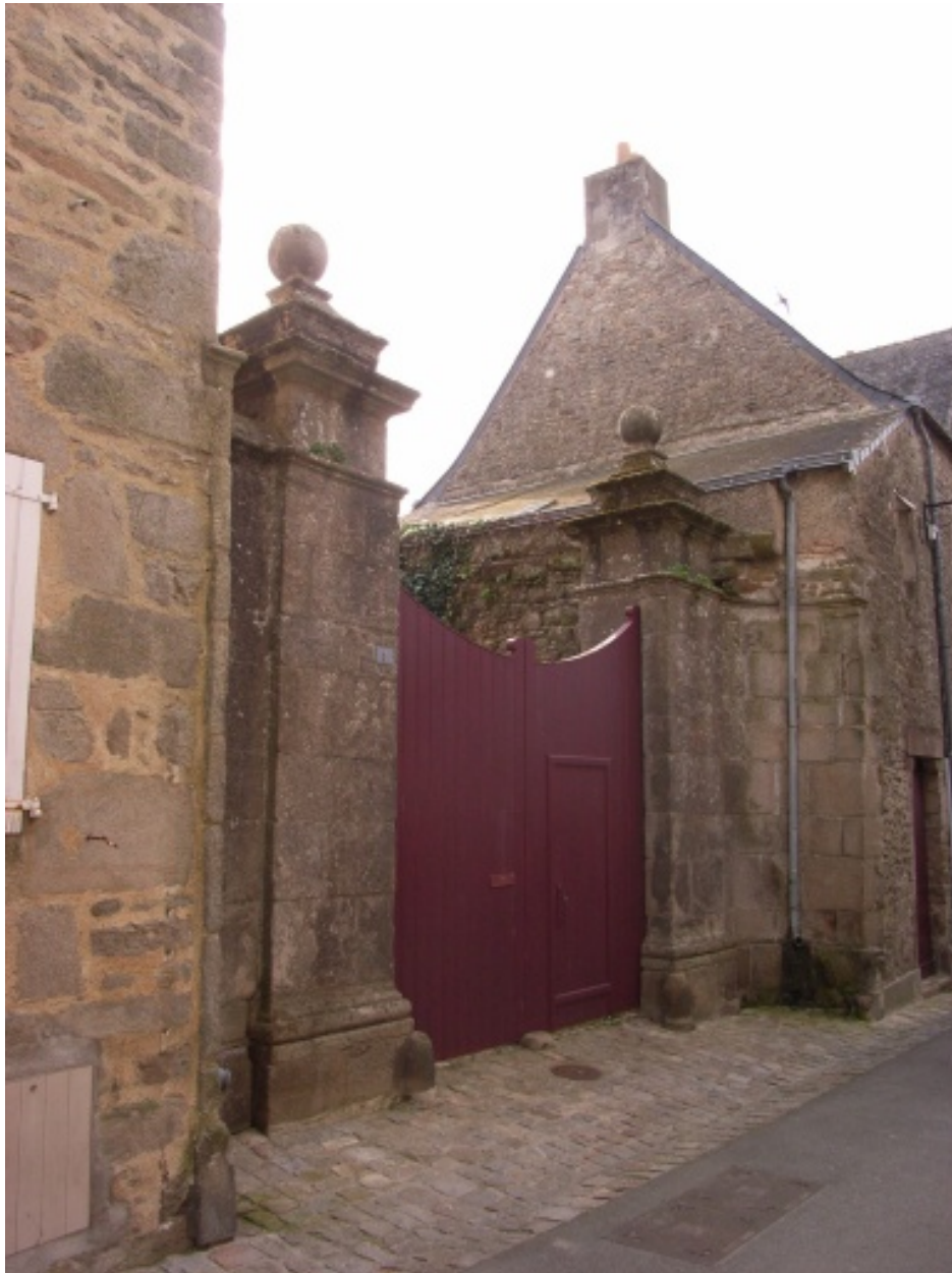
Vue du portail depuis la rue.
