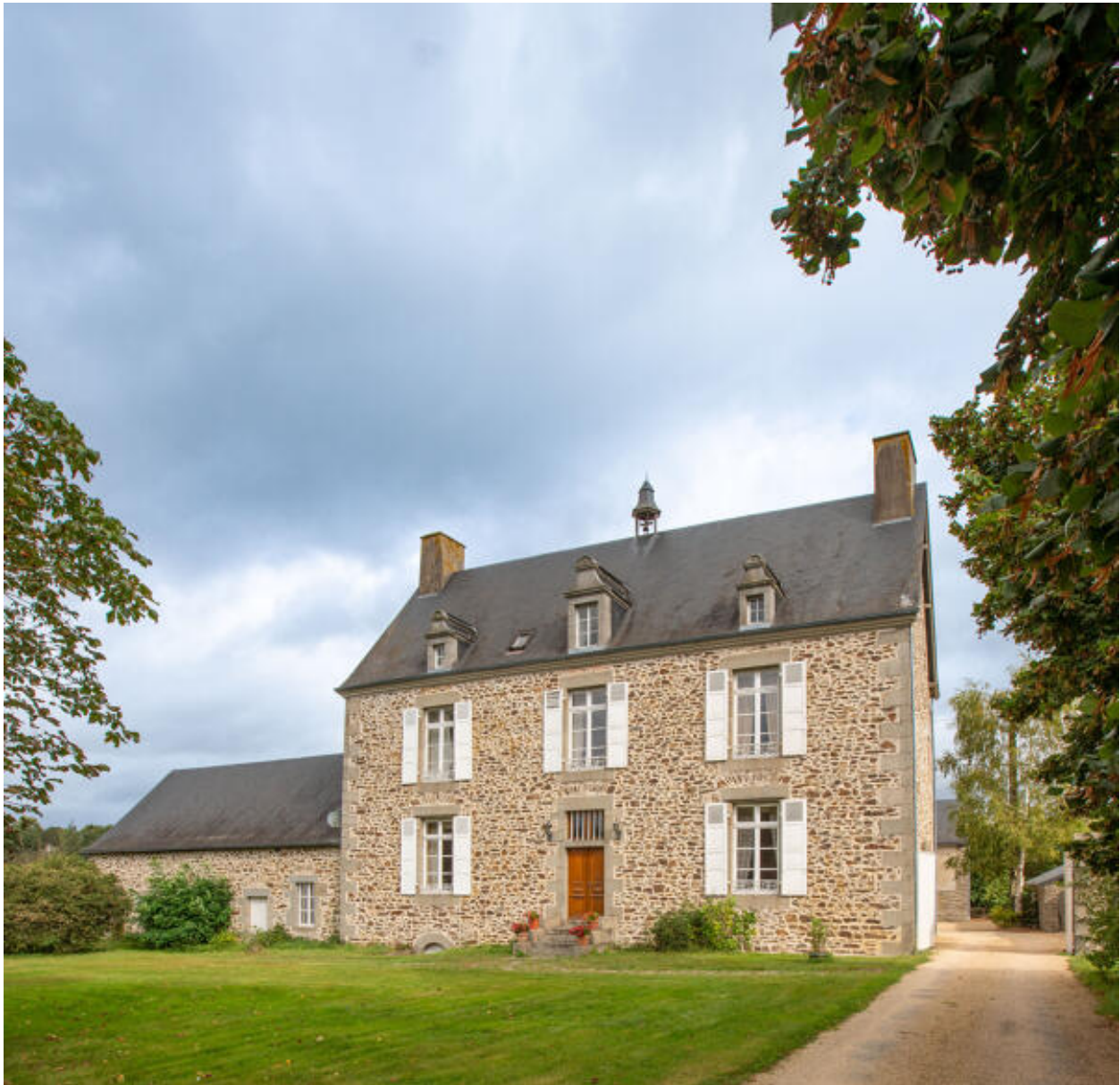
La façade antérieure de la maison.
