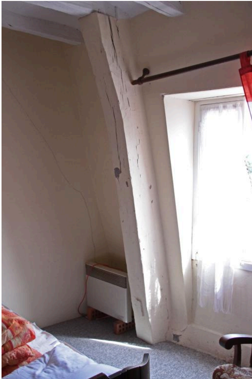
Etage de comble : arbalétrier de la charpente.
