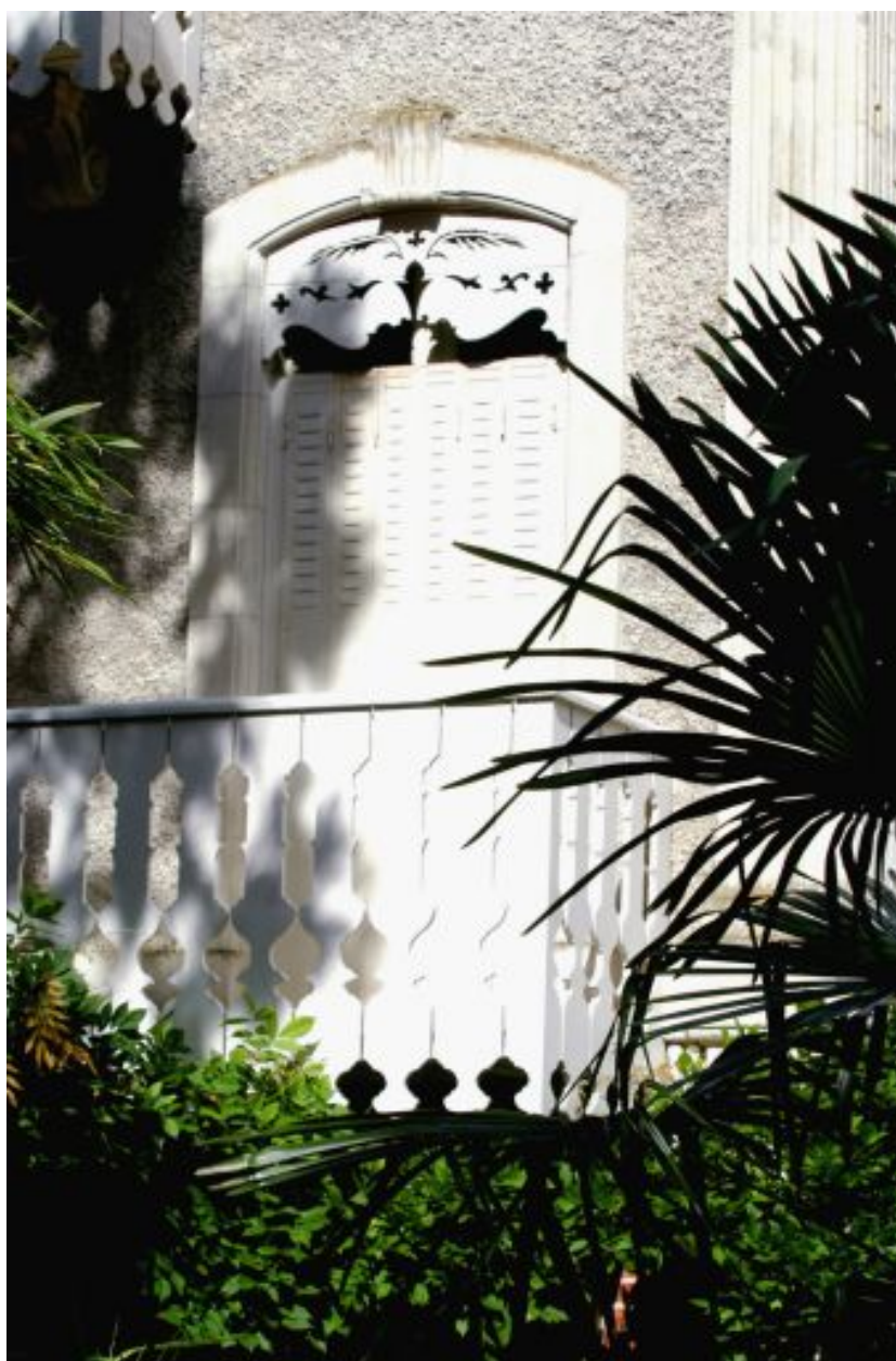
Balcon à balustres en bois découpés et lambrequin à la fenêtre.
