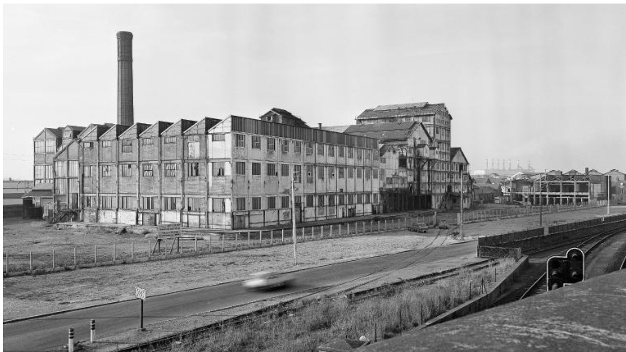
Vue générale des vestiges de l'usine depuis le nord-est.
