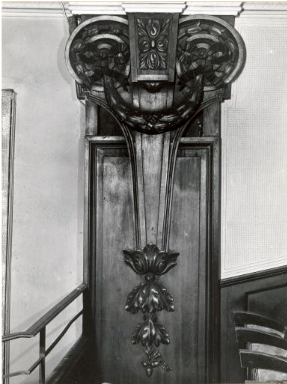
Salle de spectacle, détail d'un pilastre en bois ciré.
