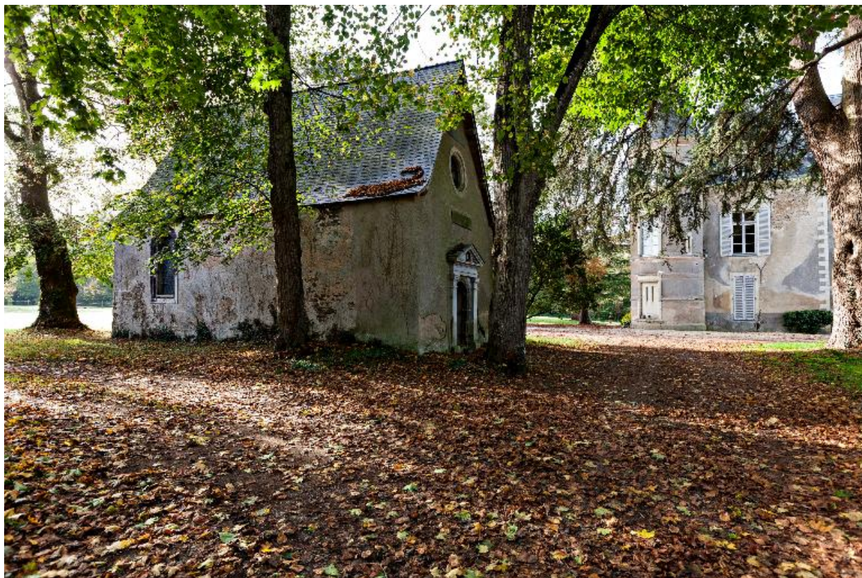
La chapelle vue depuis le nord.
