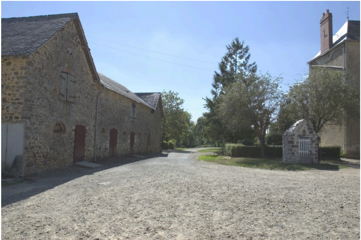
L'étable-grange et le puits vus depuis le nord.
