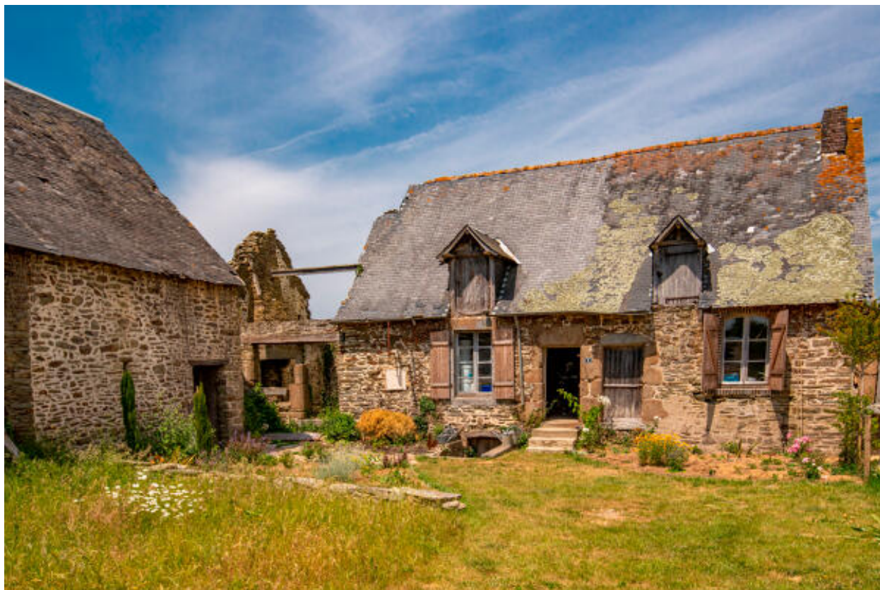
Ferme est, corps de logis central, façade sud.
