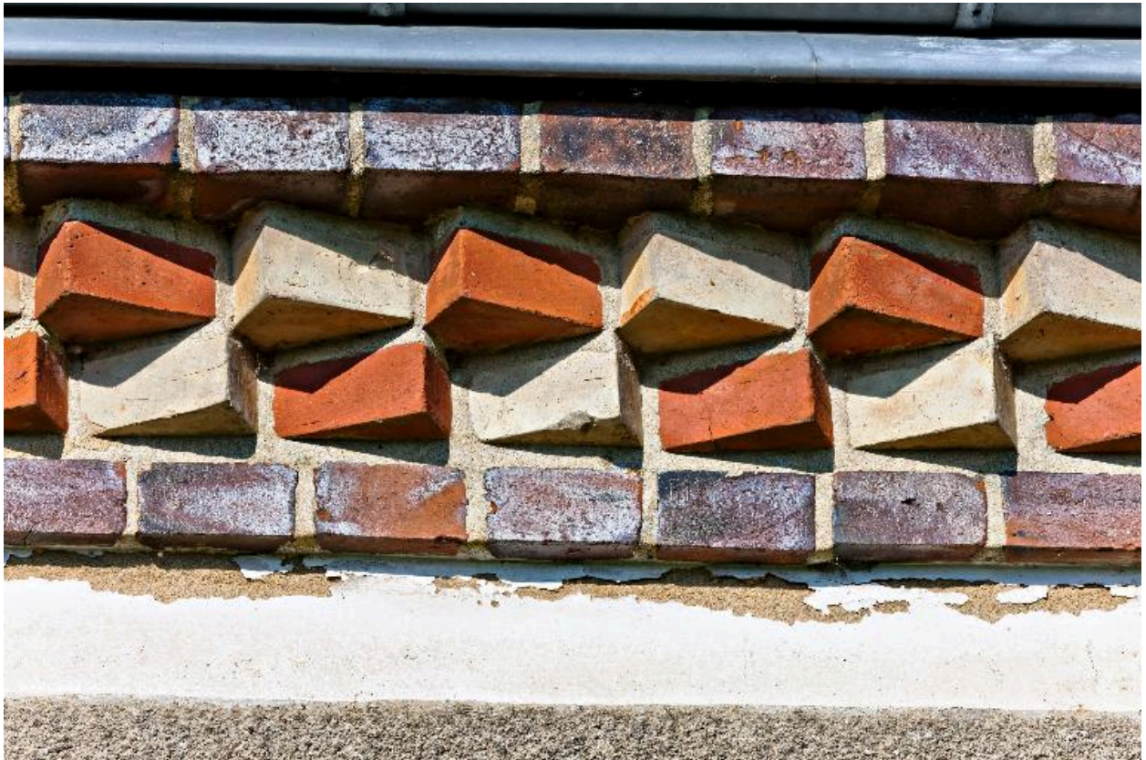
Détail de la corniche du logis de la ferme 3.
