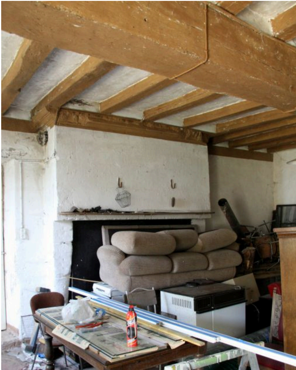
Les communs, aile ouest : cheminée.
