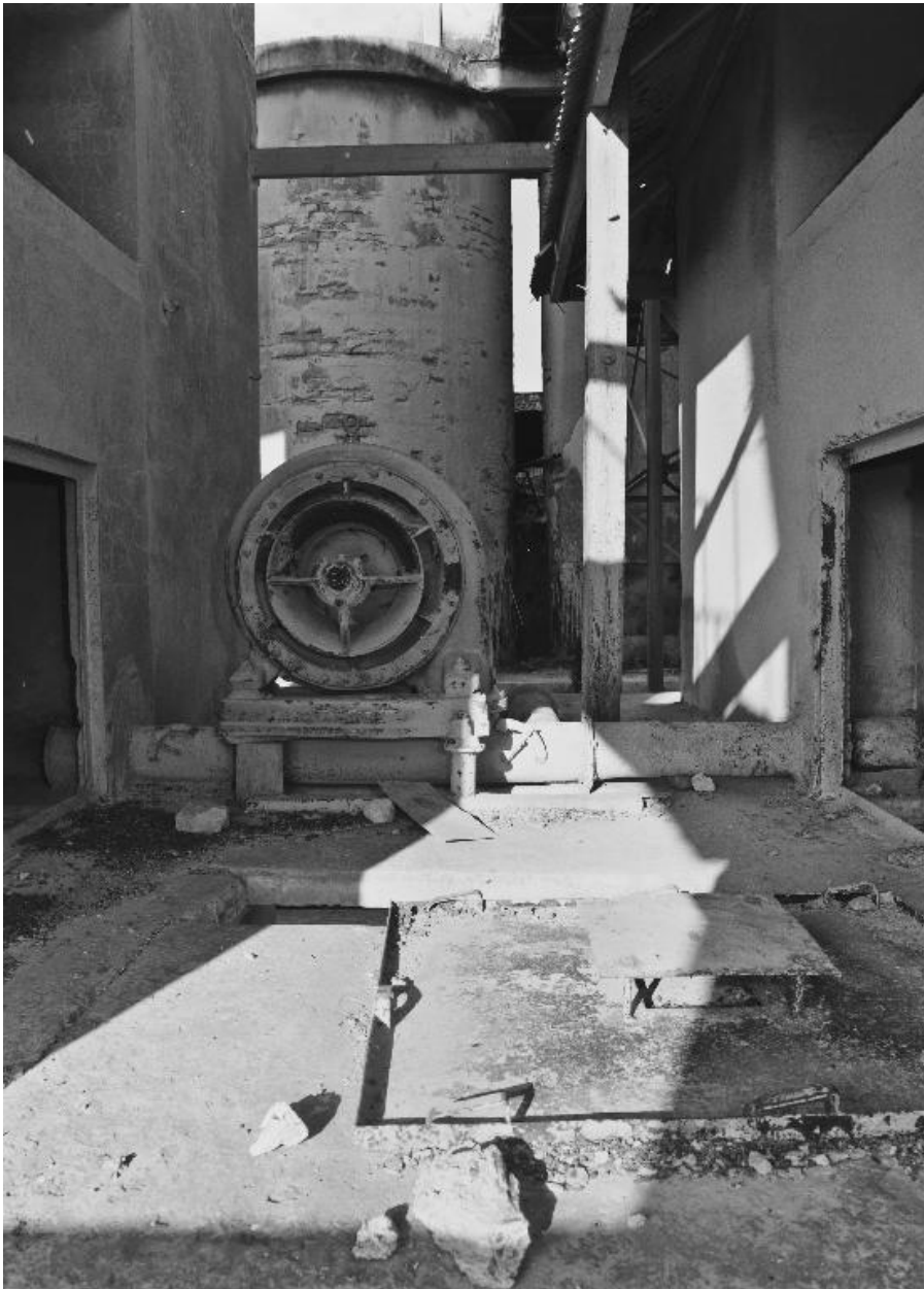
Usine de chaux ; soufflerie des fours
