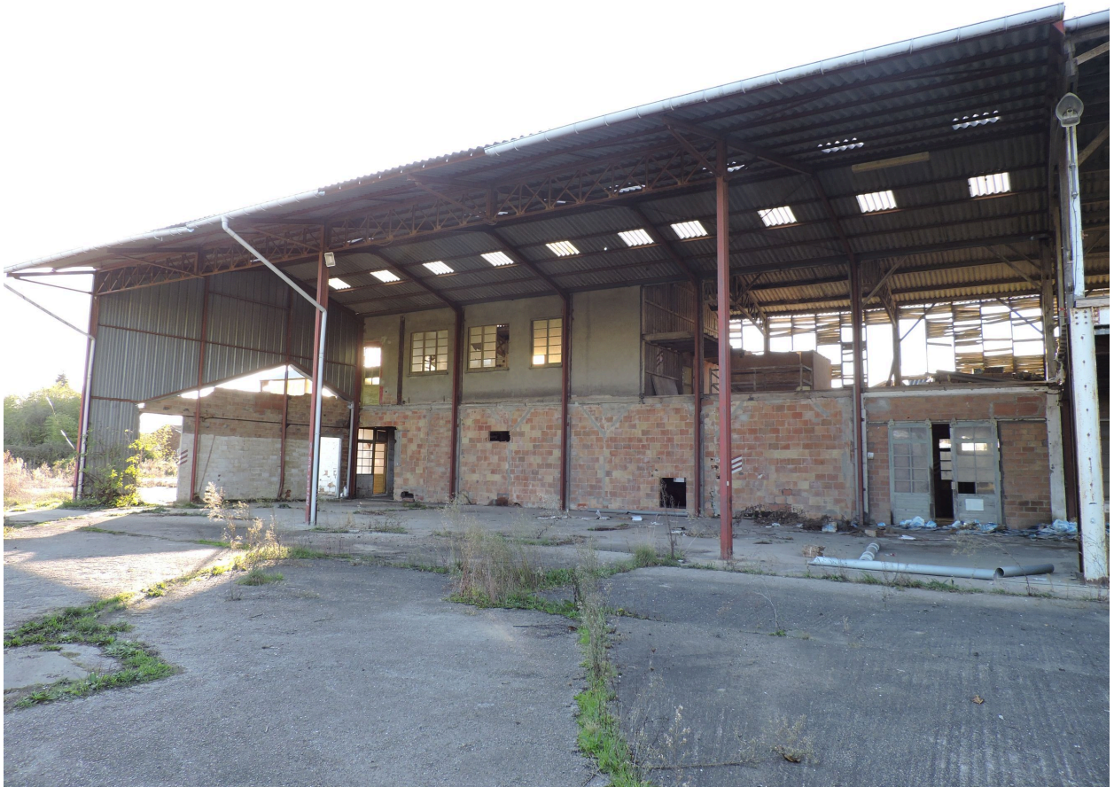
Hangar ouest, partie sud, vu depuis l'est.
