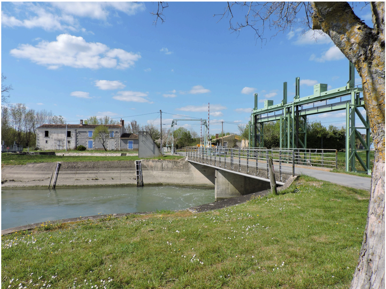
Le barrage et l'écluse vus depuis le sud-est.
