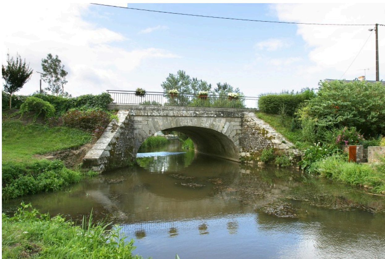
le pont vu d'amont, depuis le nord.
