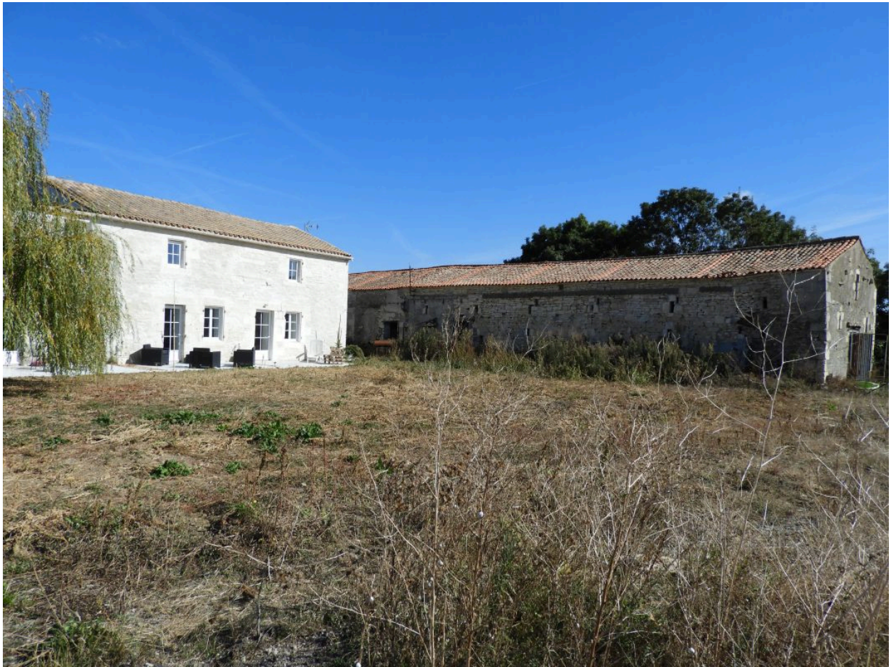
Le logis et la grange-étale vus depuis le sud-ouest.
