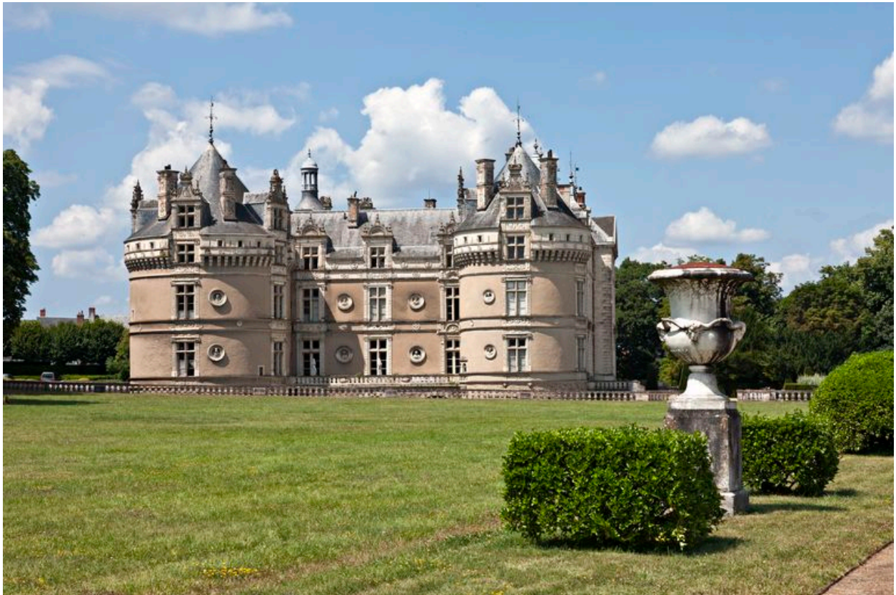
L'aile sud vue depuis la grande terrasse.
