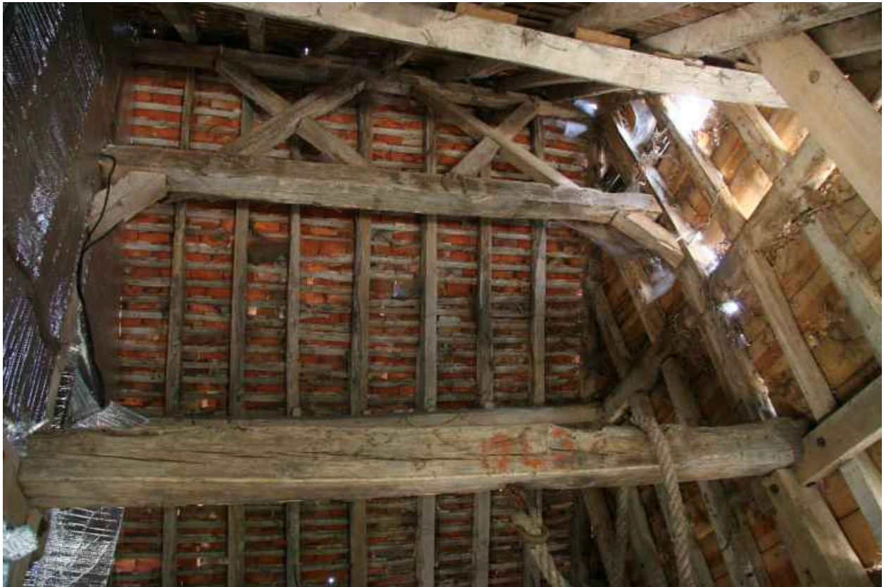
Charpente à pannes avec double sous-faîtage.
