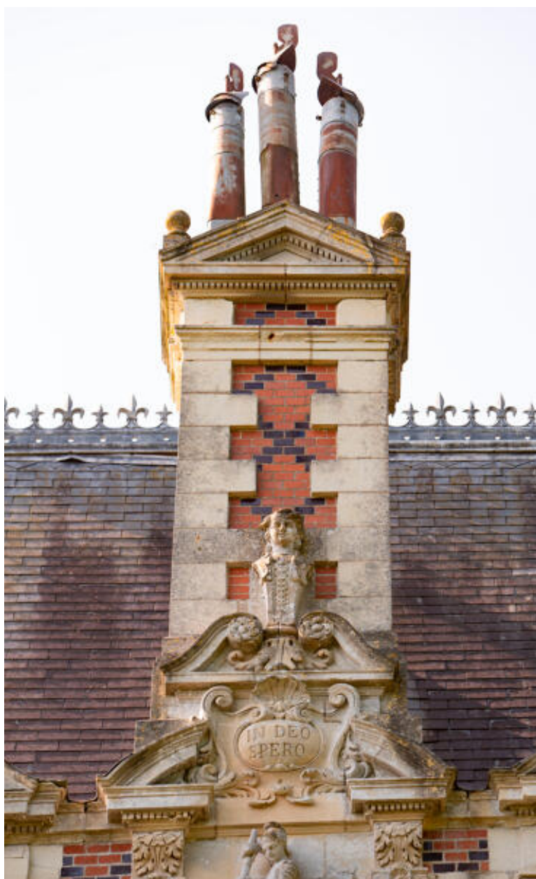
Le pavillon nord-est, souche de cheminée
