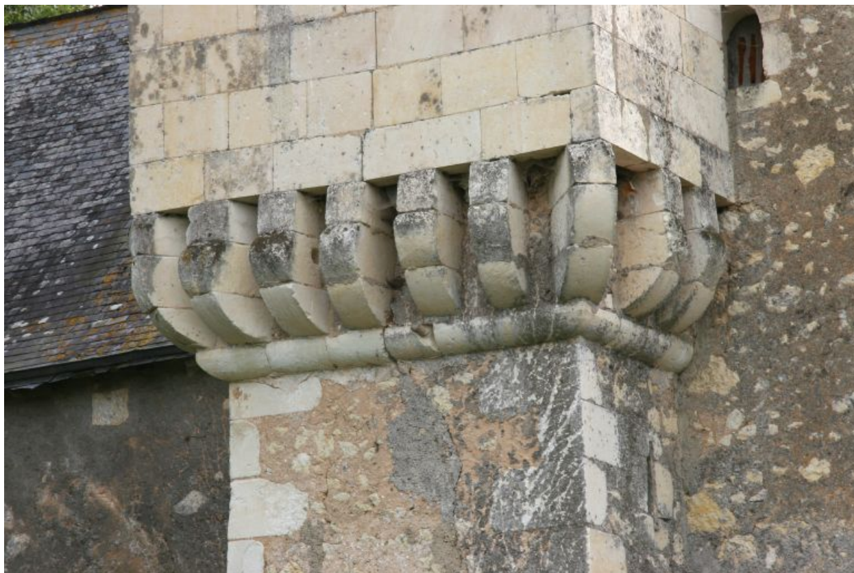
Encorbellement des latrines.
