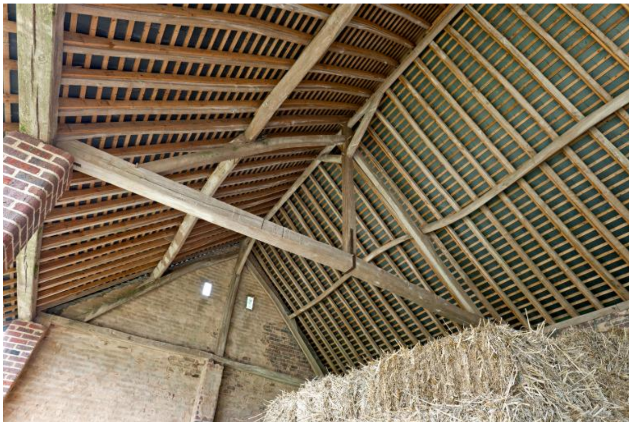
Hangar agricole : charpente.
