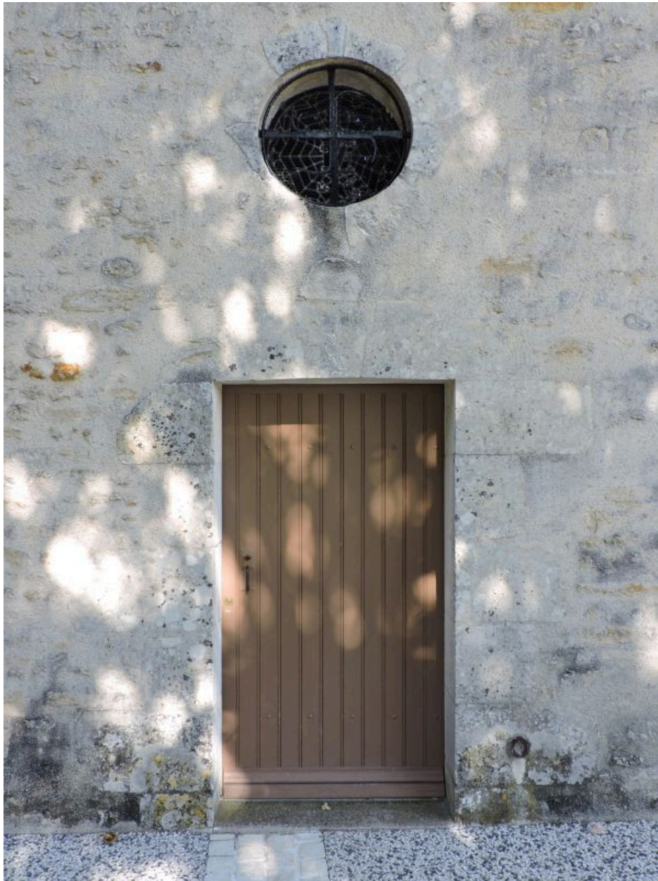
La porte et l'oculus dans le mur sud.
