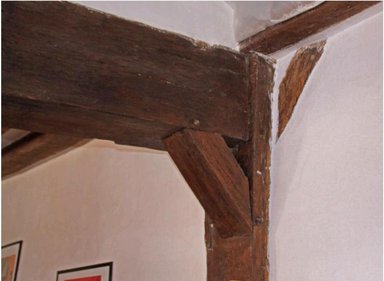
Logis, rez-de-chaussée : vestige d'une structure porteuse en bois sur le mur postérieur.
