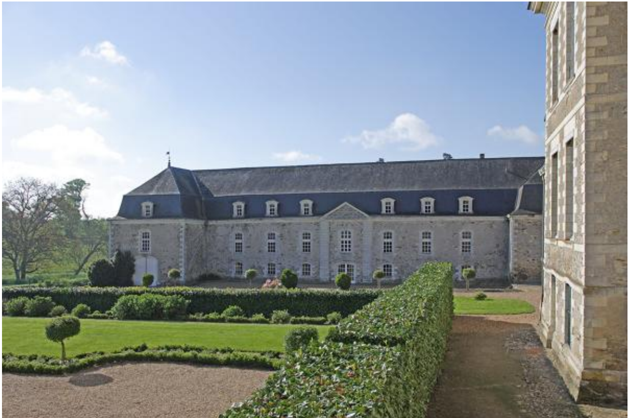
Le corps de commons dit "grange d'abondance", élévation antérieure.
