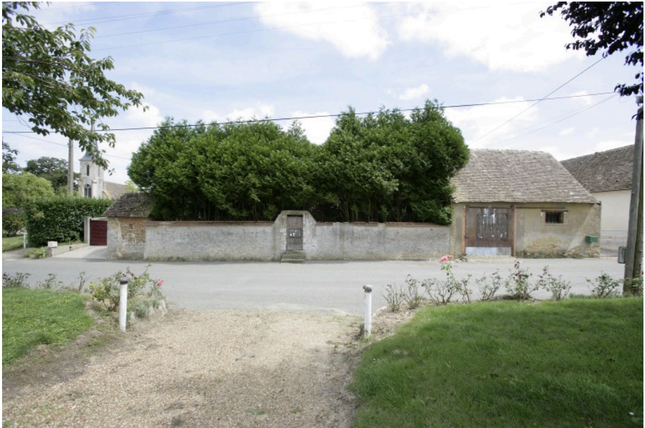
Presbytère, mur du parterre vu depuis la rue. À gauche, le bâtiment des latrines, à droite la remise incluant les anciennes étables.
