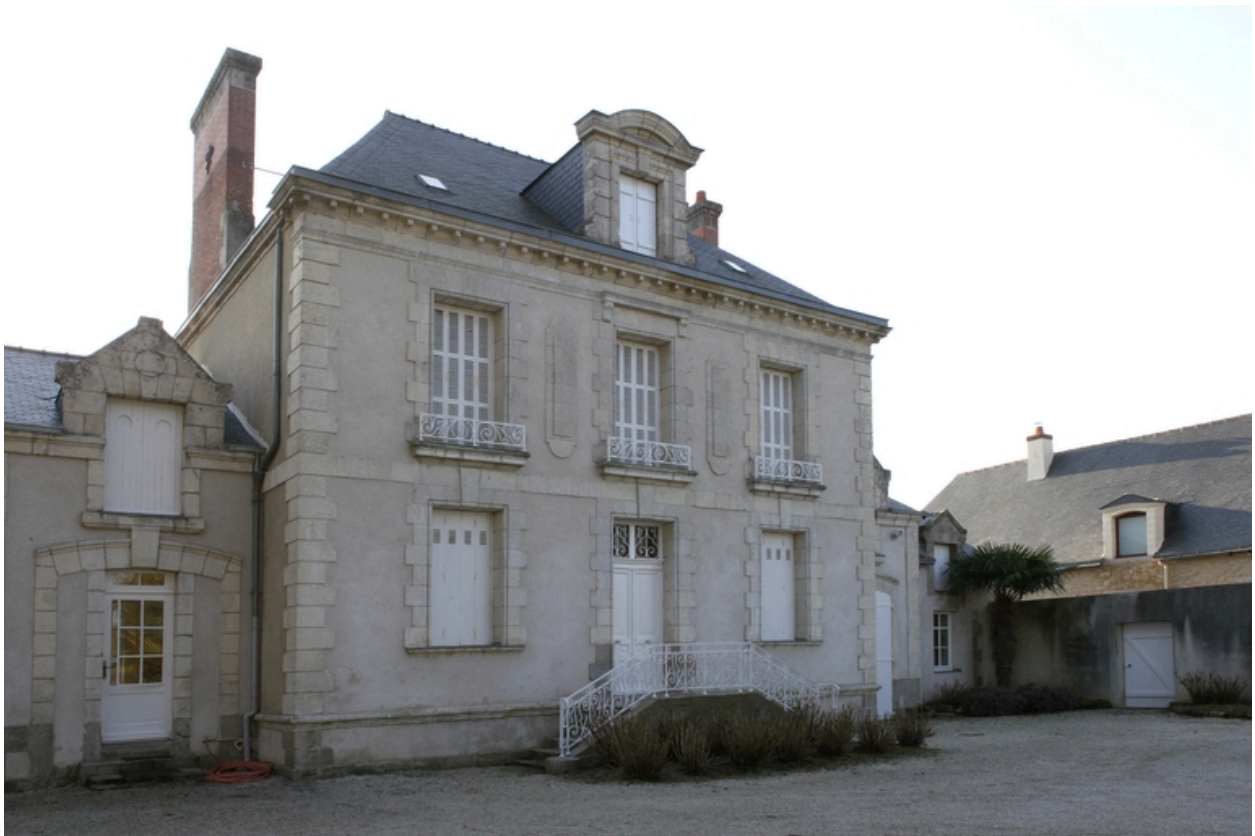
Vue de la façade nord depuis le nord-est.
