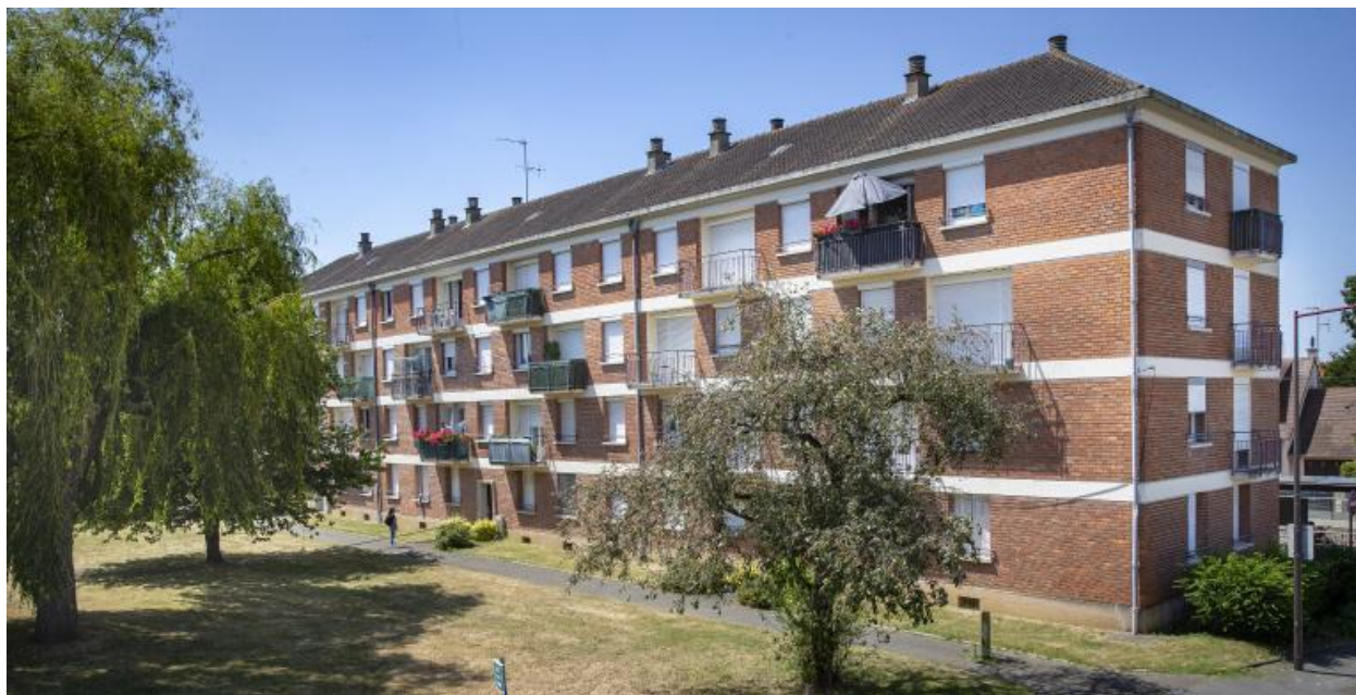
Vue du bâtiment B2 depuis le parking rue de l'Osier.
