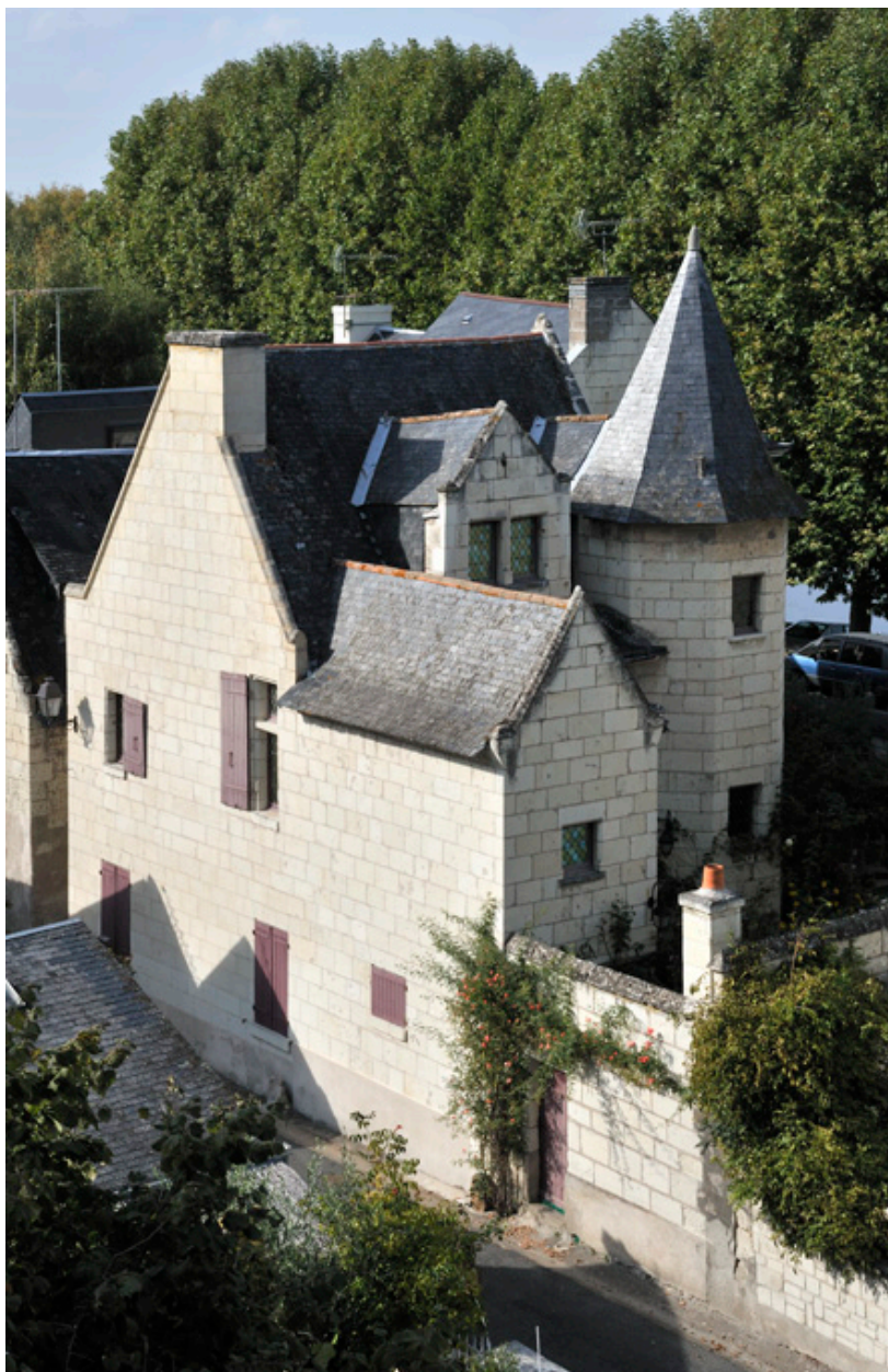
Vue générale depuis la Haute rue.
