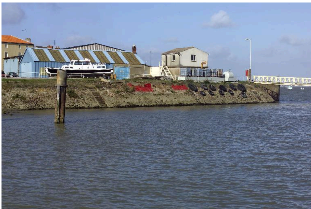
L'entrée du bassin de carénage, vue vers la Loire.
