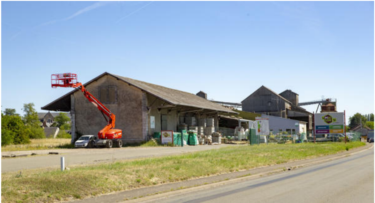
L'ancienne halle à marchandises.
