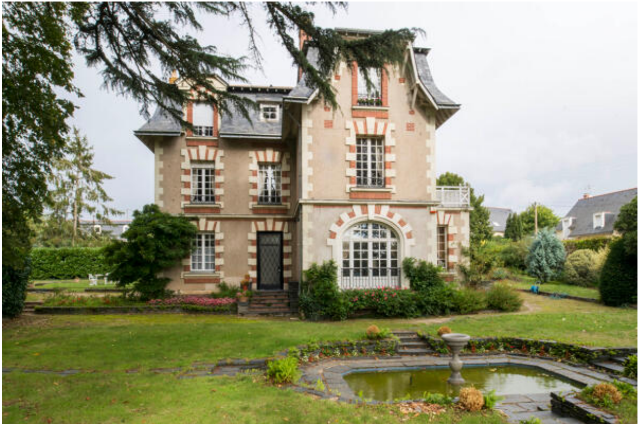
Vue de la façade sud et du jardin.
