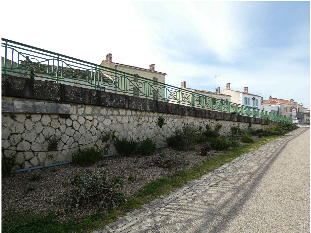
La rampe d'accès au pont, rive droite, vue depuis l'est.
