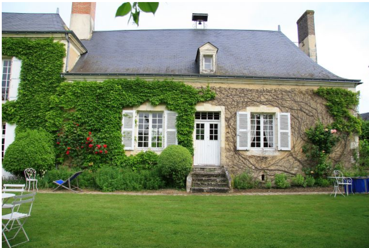
Aile basse, façade sur le jardin en rez-de-chaussée surélevé.
