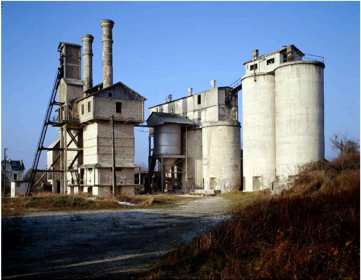
Vue d'ensemble de l'usine de chaux, prise du sud-est
