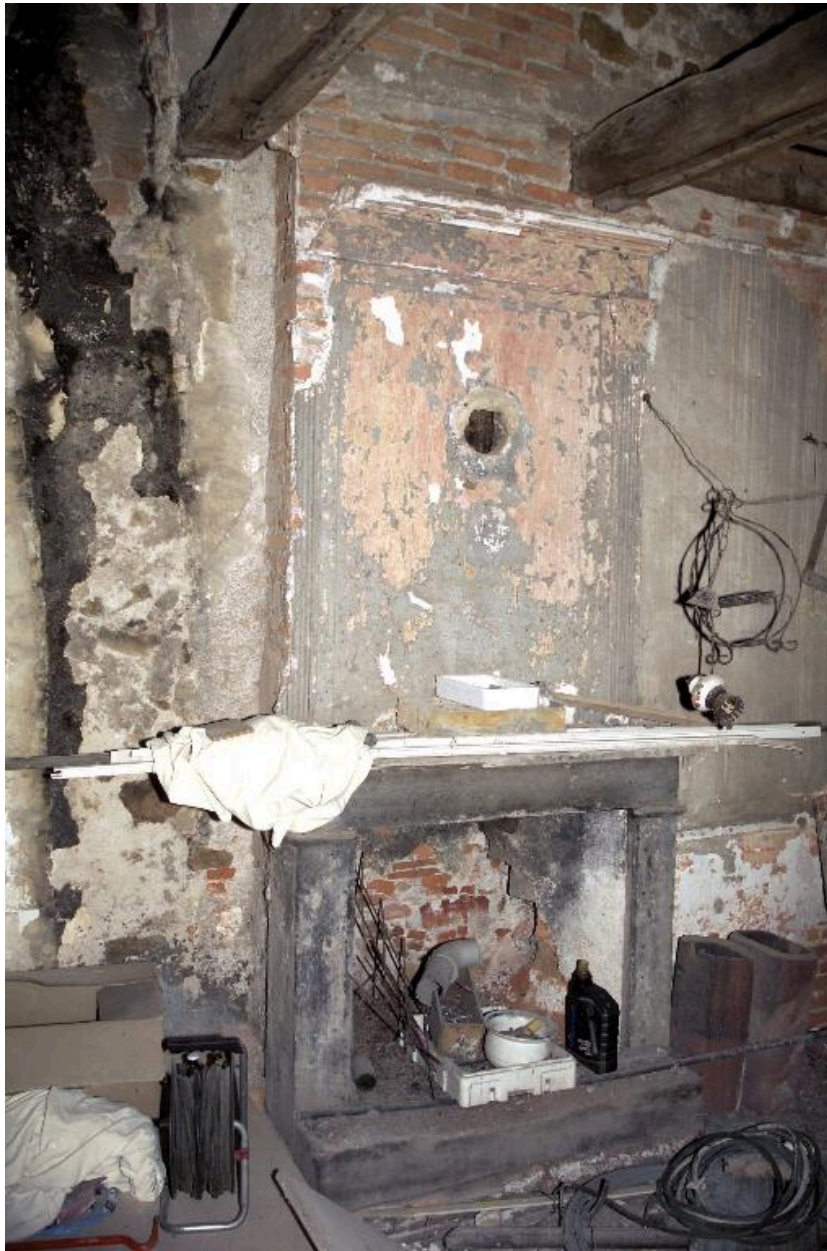
Le corps secondaire à l'est de la cour, la cheminée du rez-de-chaussée.
