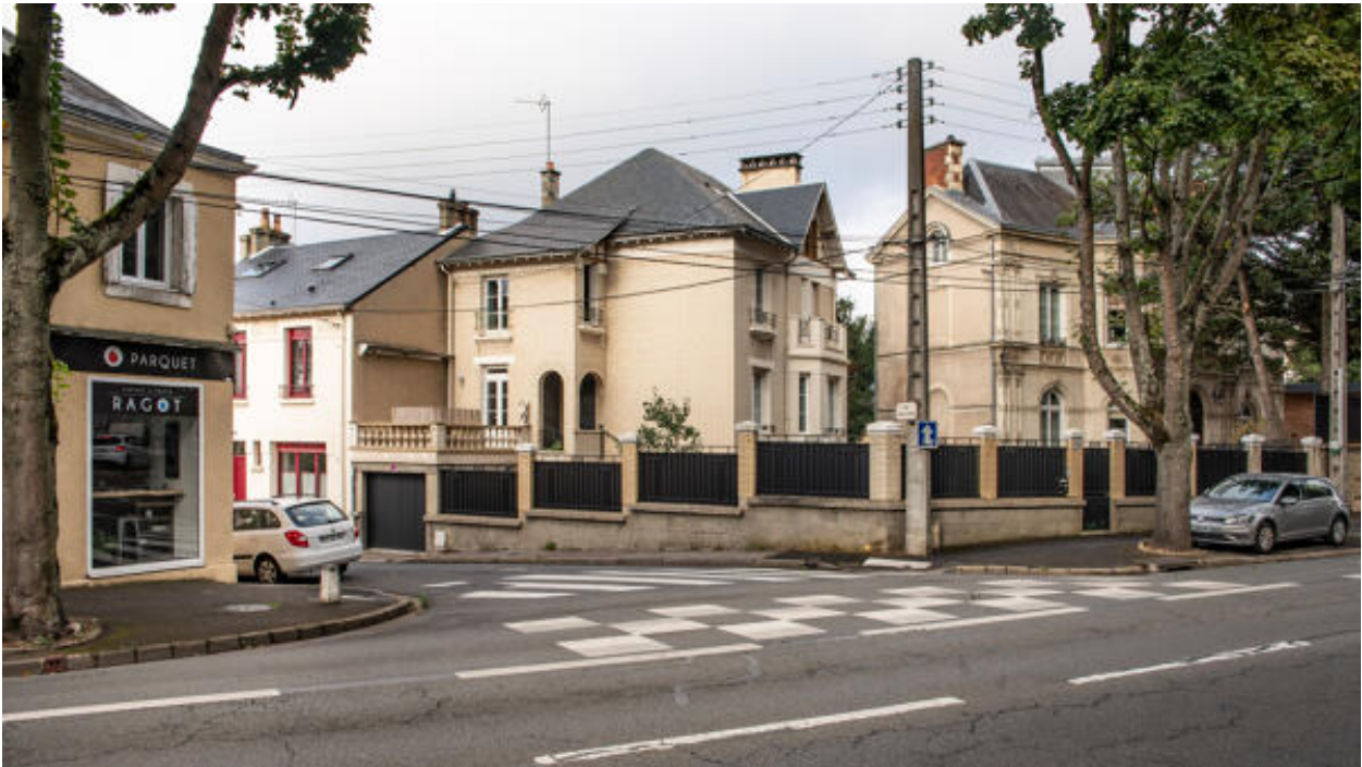
Vue du croisement de l'avenue Bollée et de la rue Claude-Hilleret.
