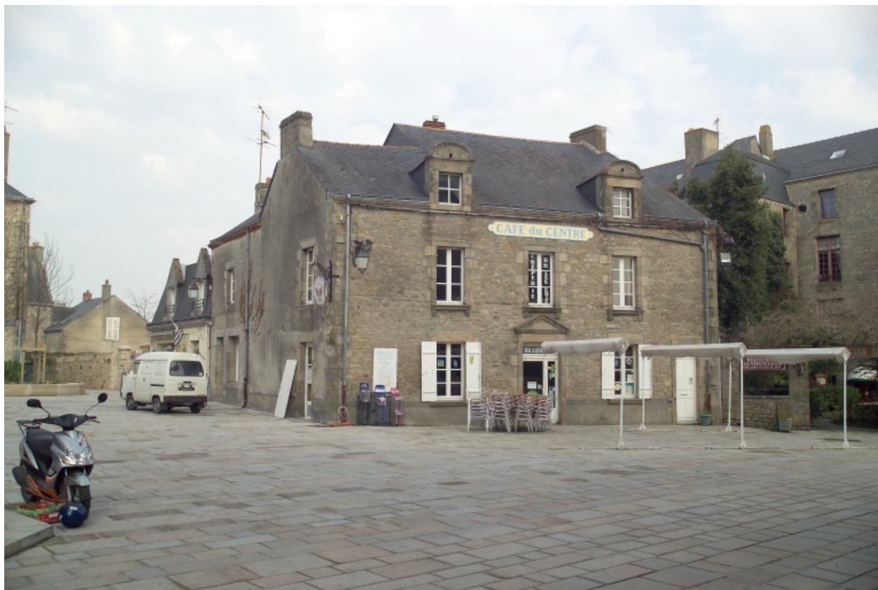
Vue générale vers le Nord-Ouest.
