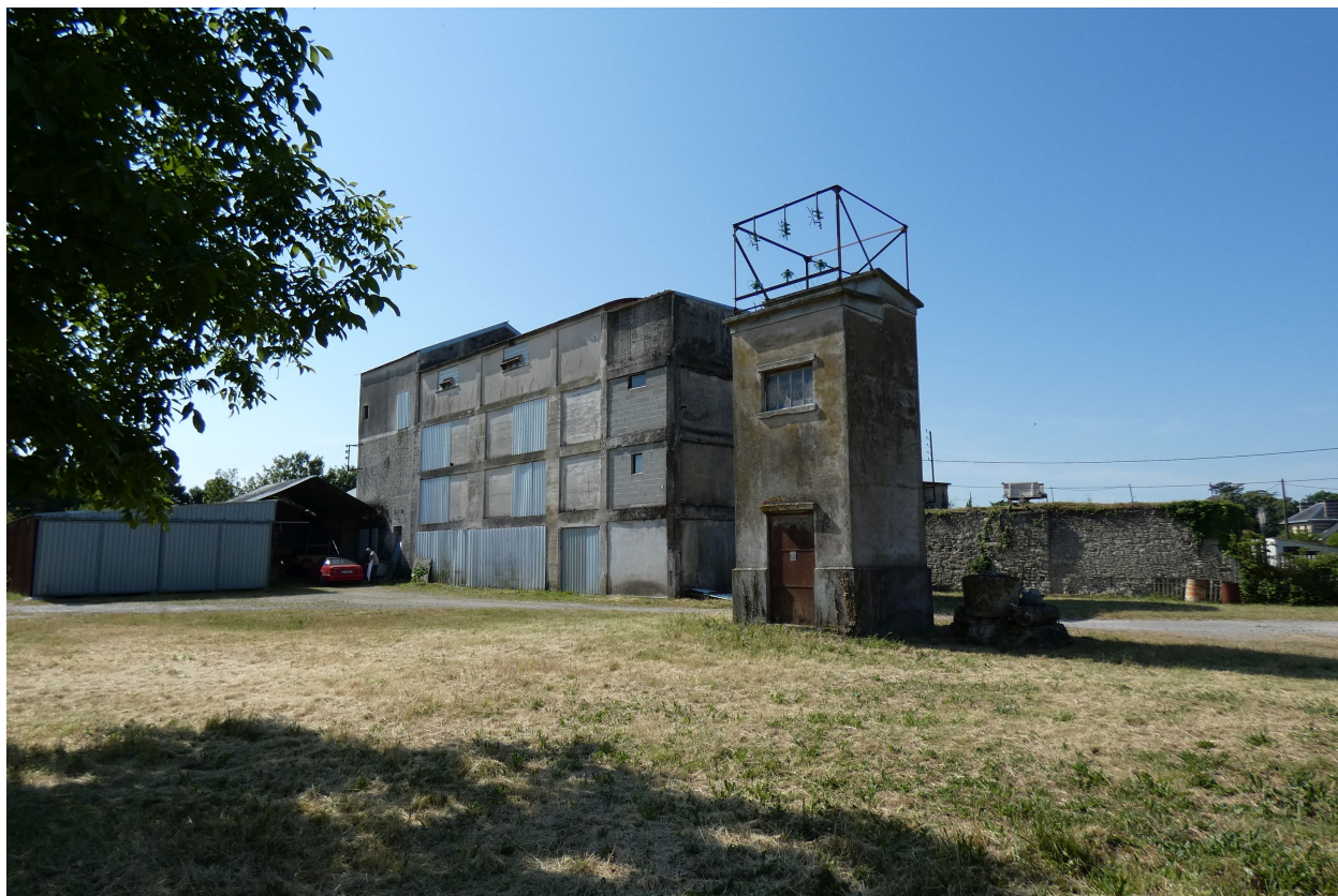
La bluterie et le transformateur vus depuis le nord.
