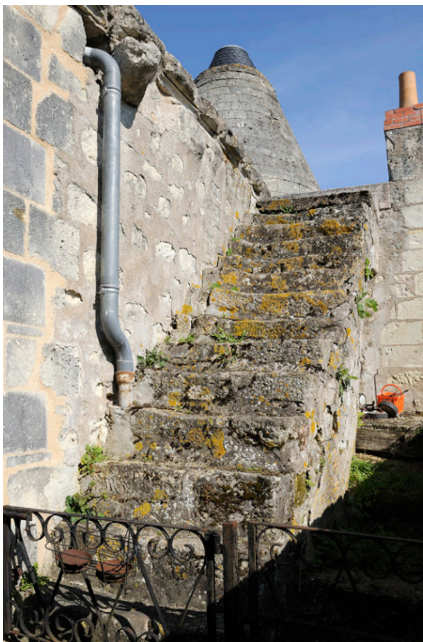
Moulin Neuf : escalier extérieur
