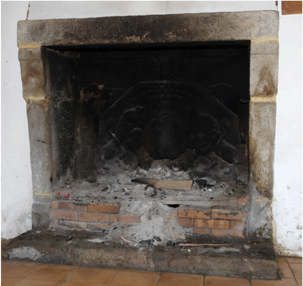
Logis. Partie est. Détail de la cheminée du rez-de-chaussée.
