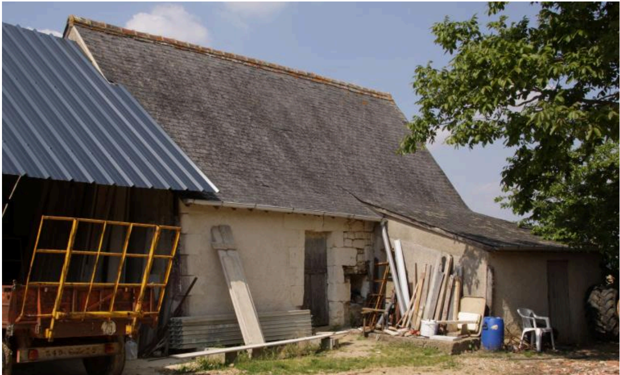
Maison : façade antérieure.
